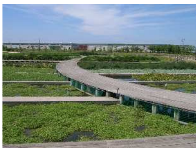
礫間接触池(上)及び植生酸化安定池(下) (甲子園浜浄化センター)
