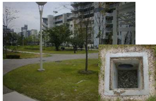
透水性舗装・雨水浸透柵の事例(浜甲子園団地)
