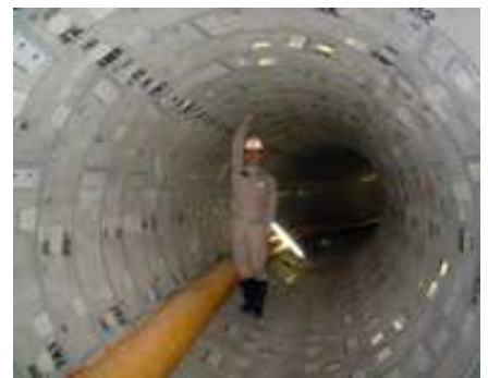
浸水対策用雨水貯留幹線
