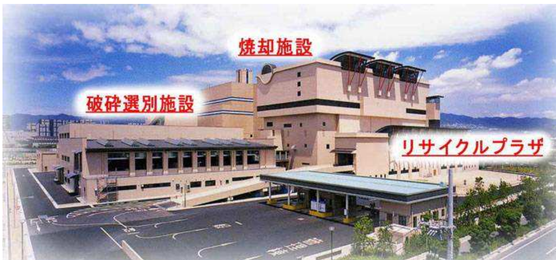
■西部総合処理センター■
