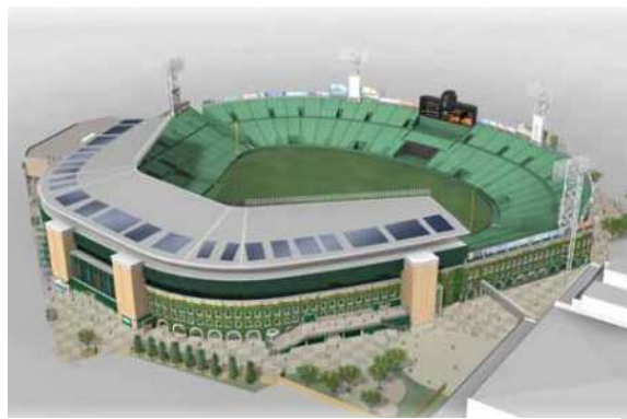
阪神甲子園球場銀傘への太陽光発電設備設置 出所：阪神電気鉄道株式会社
