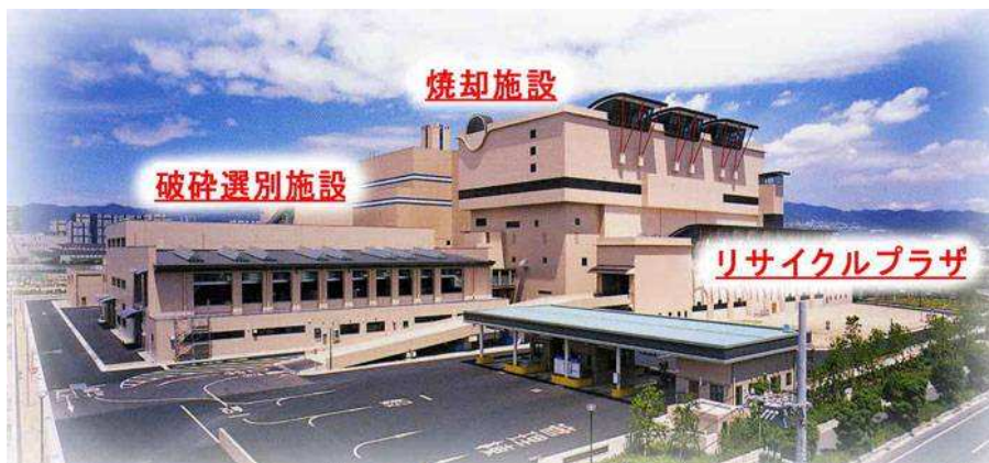
西部総合処理センター
