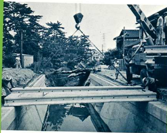
● 駅前中新田川橋梁架設工事
