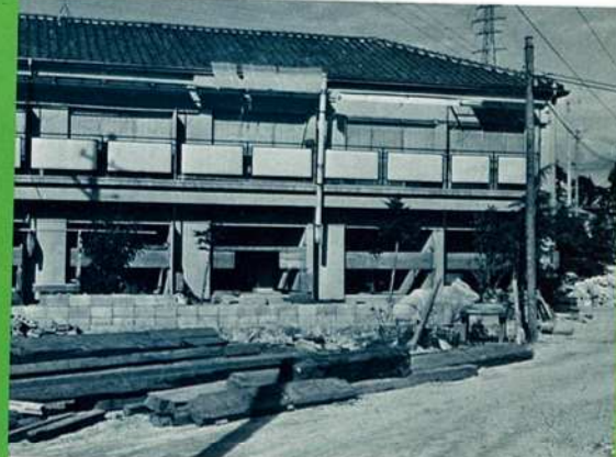
● 松風町曳去り移転工事
