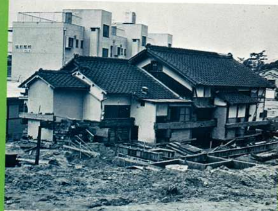
● 南越木岩町曳去り移転工事
