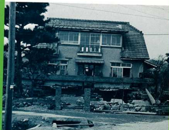
● 豊楽町曳去り移転工事
