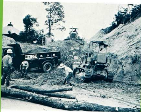
● 菊谷町区画街路工事
