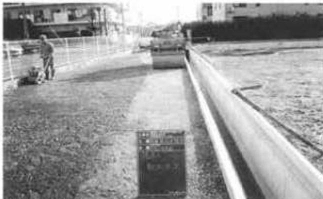
・区画道路側溝工事
