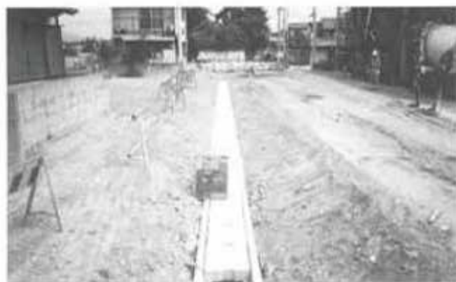
・区画道路側溝工事
