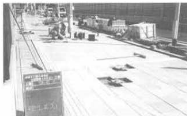
・車庫北線歩道平板舗装工事
