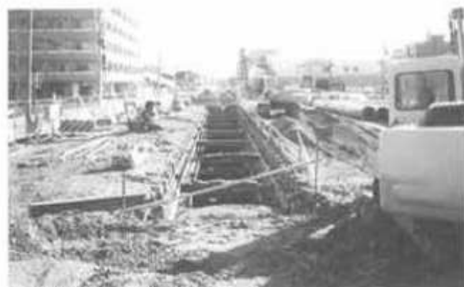
・武庫川広田線汚水幹線移設工事
