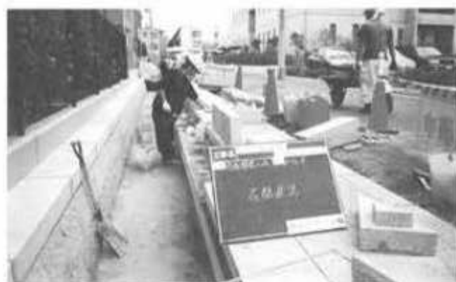
・せせらぎ通り石張り舗装工事
