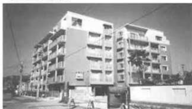
・竣工した6階建ての共同住宅
