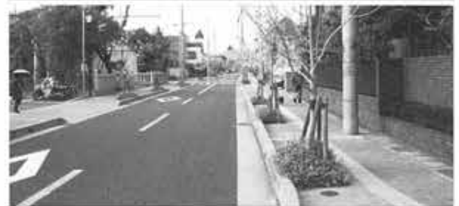
・セミフラット型で整備された高木2号線
