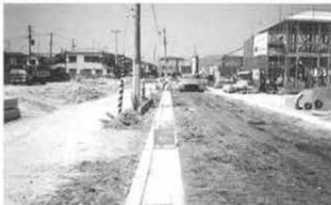
・区画道路側溝工事
