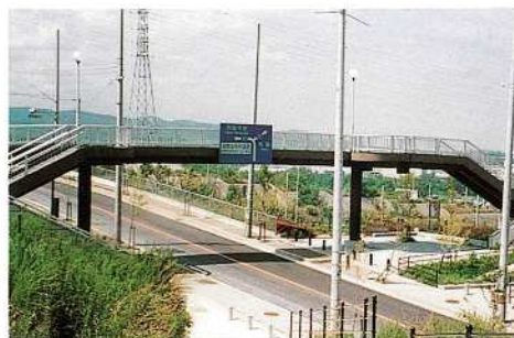
樋ノ谷歩道橋
