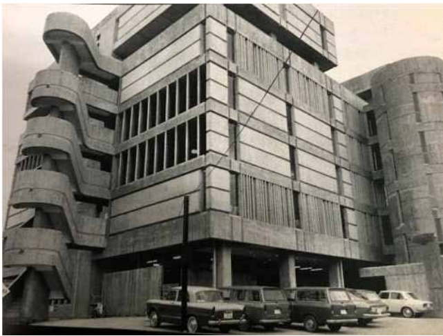
竣工当時の西宮市民会館。昭和 42（1967）年
