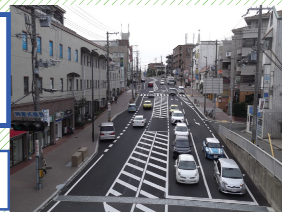
施工後 平成 29 年
