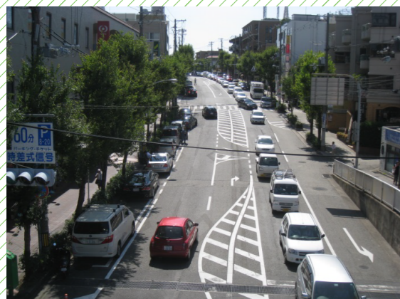
施工前 平成 25 年
