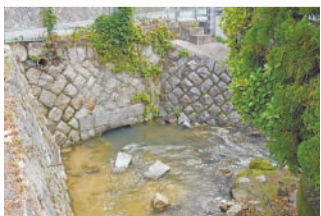
▲仁川の川底をくぐった先の出口部分の様子(百間樋児童遊園南側)
