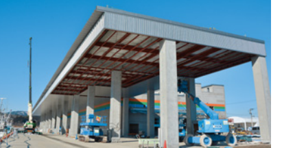
水産業の中核として期待される「南三陸町地方卸売市場」は急ピッチで建設が進む
