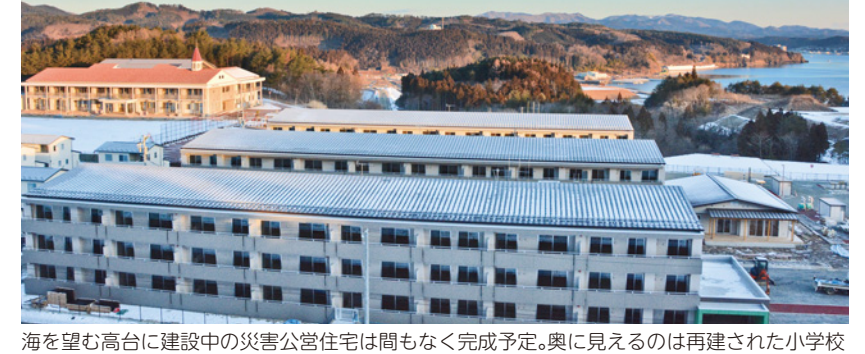
海を望む高台に建設中の災害公営住宅は間もなく完成予定。奥に見えるのは再建された小学校
