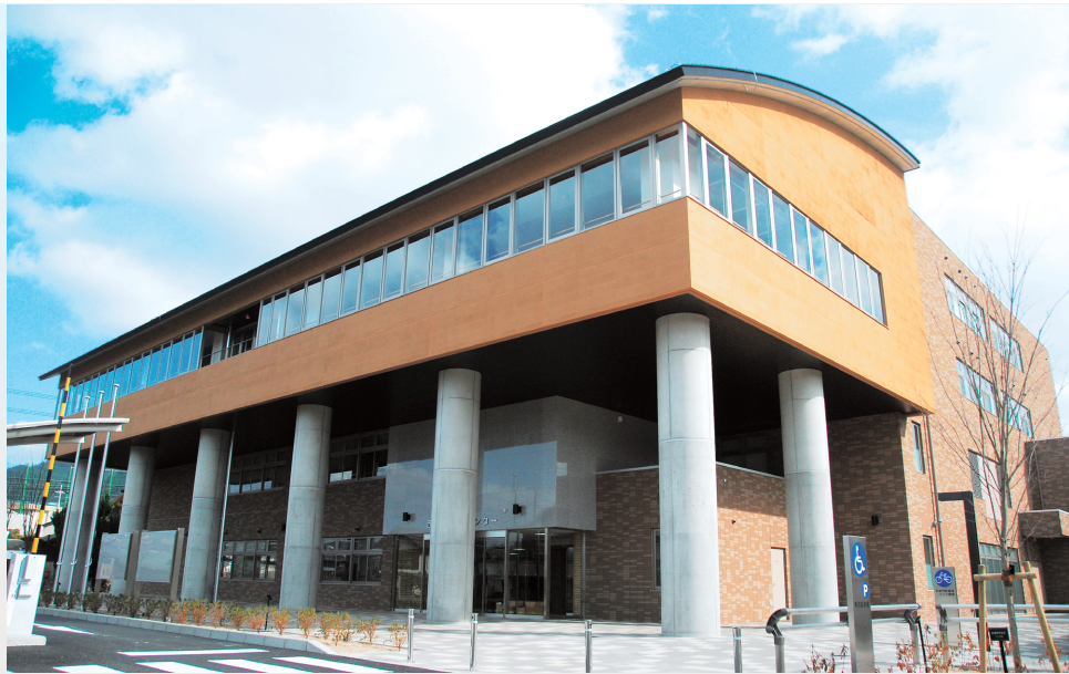
ハイブリッド照明灯を設置するなど、自然環境にも配慮した複合施設「山口センター」。皆さんの暮らしと健康を応援するサービスの提供を一層進めていきます。
