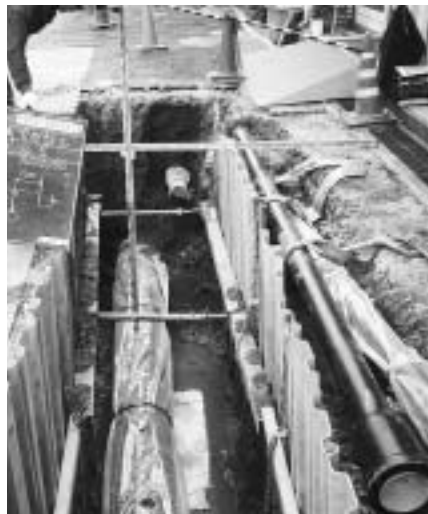
配水管の耐震化布設替工事(社家町で)
