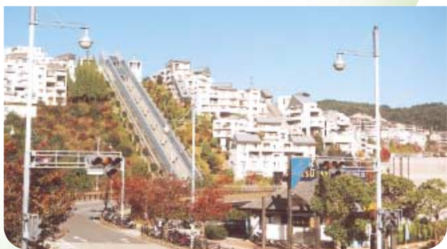
「R西宮名塩駅と住宅街を結ぶ斜行エレベーター」
