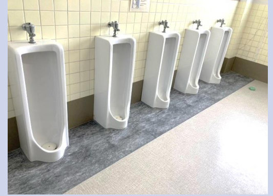
（改修後のトイレ）
