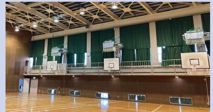
（空調設備整備後の体育館）
