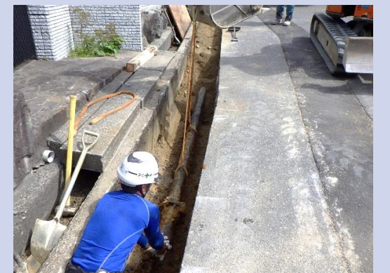
(水道管の布設工事の写真)
