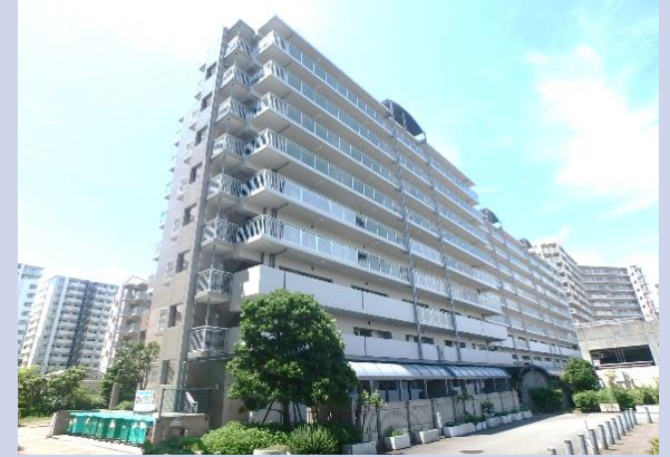
（外壁改修後の市営住宅）
