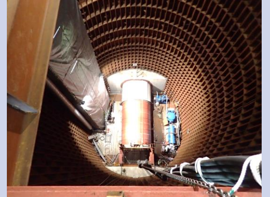
（合流貯留管の整備）
