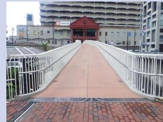
（羽衣町歩道橋）
