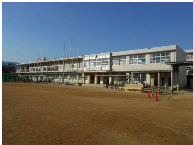
瓦木中学校現況
