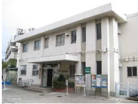
甲陽園市民館現況
