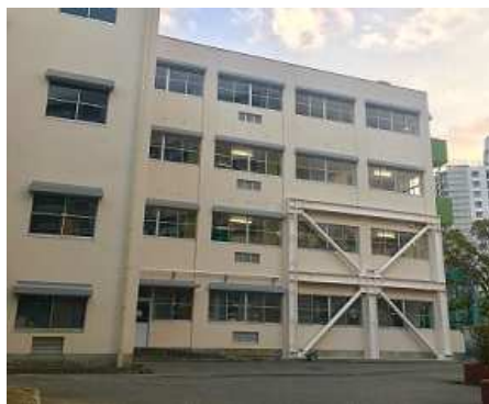
改修後の校舎
