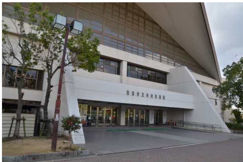
中央体育館現況
