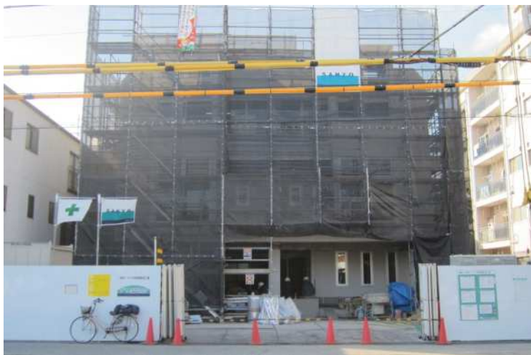
平成30年4月開園に向けて工事中の新設保育所
