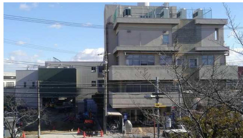
新築工事中の（新）いずみ園と福祉会館
