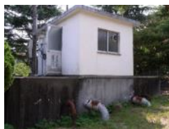
② 鷺林寺南中継槽
