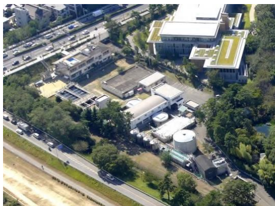
【 鳴尾浄水場（戸崎町） 】
