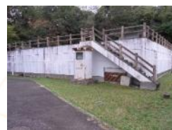
⑥ 北山配水所
