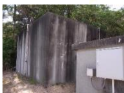
⑤ 剣谷配水槽
