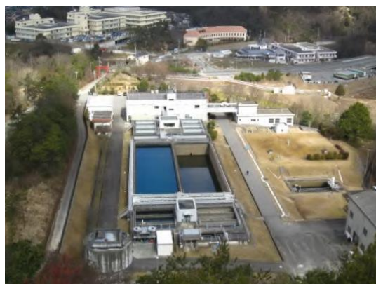
【 丸山浄水場（山口町下山口） 】
