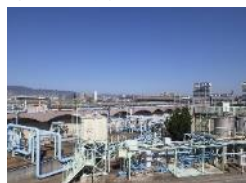
⑫ 枝川浄化センター
