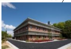
⑦ 越水浄水場
