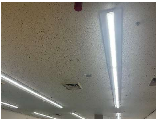
<2階第4作業室天井>
