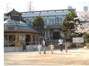
図 5-6 甲山自然環境センター
