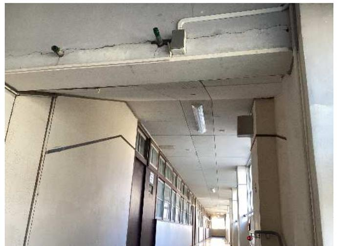
校舎のつなぎ目には耐震対策が施されているものの、段差によって車いす等の移動が極めて困難となっており、インクルーシブ教育の観点からすれば極めて施設課題の大きい事案と言える。ネット情報によれば、自走用車椅子に乗って自分でスロープの上を移動する場合、スロープの長さは段差の約12倍、傾斜角度は5度以下と推奨されている。中学校施設の階段踏み面は約24cmとされているので、最も段差の多い場所にスロープを設置する場合約23メートル必要となる。仮設での対応は困難であり、各所にエレベータを設置することも費用的に困難である。
