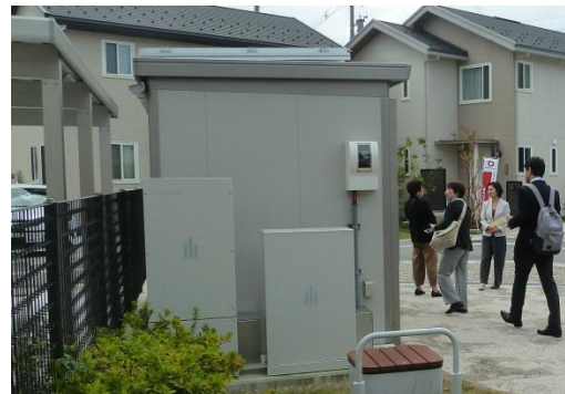
街区内の住宅と手前に防災備蓄倉庫
