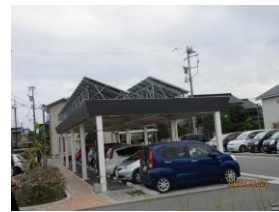
↑太陽光パネル
