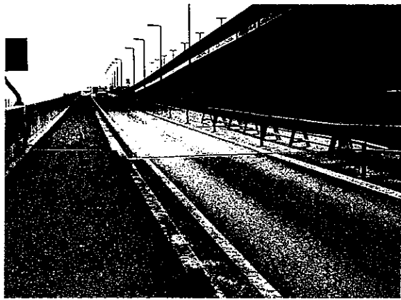
■阪神高速5号湾岸線の側道の鳴尾橋周辺
