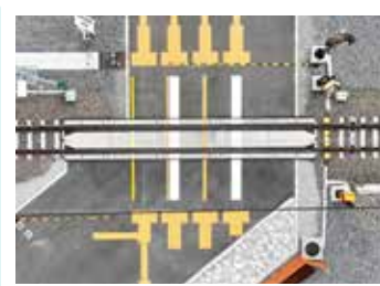
視覚障害者誘導用ブロック等の設置及び構造に関する実験 (国土交通省)
