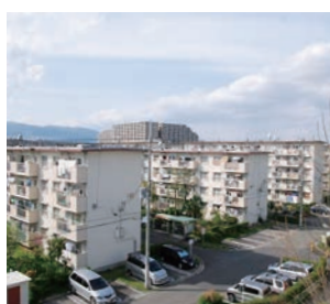
建て替え事業中の浜甲子園団地
