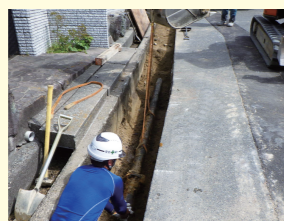
不要となった管の撤去作業
