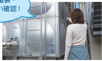
受水槽の目視確認
