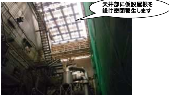
焼却棟除染工事(電気集じん器内部除染工事)
