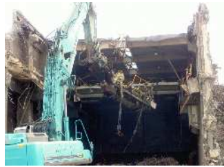
ごみクレーン解体状況
