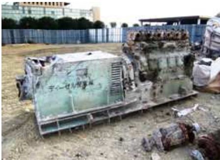
プラント機器撤去(非常用発電機)
