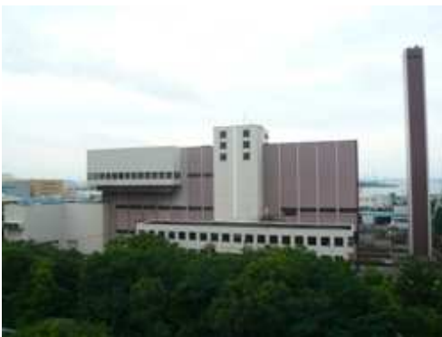
既存焼却施設(西側より)
