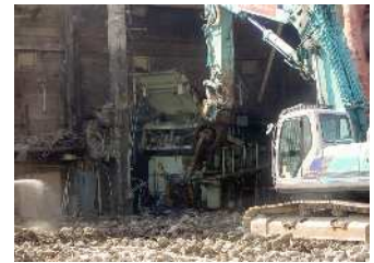
破碎機解体状況
