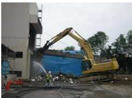
破砕選別施設地下部分解体
