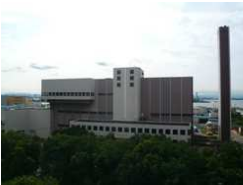
既存焼却施設(西側より)
