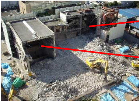
ごみクレーン及び破碎機を解体しています。
