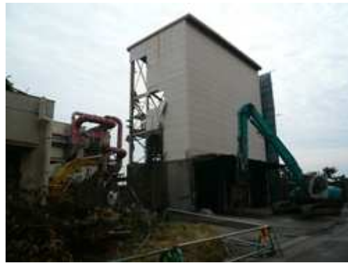
破碎選別施設の一部（機械選別棟）解体
