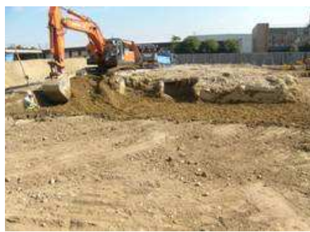
破砕選別施設地下部分解体
