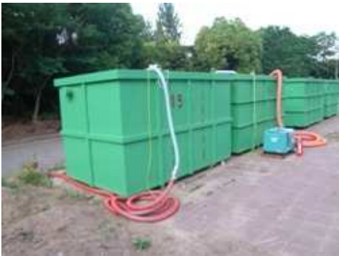
残留水の仮設排水処理装置の設置
