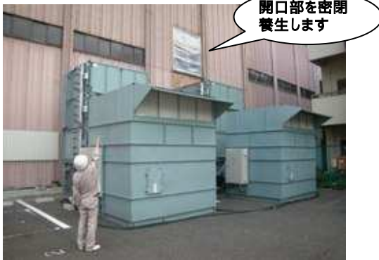
焼却棟建物の密閉養生、仮設集塵装置の設置
