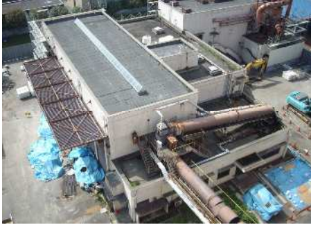
破碎棟解体工事着手前状況
