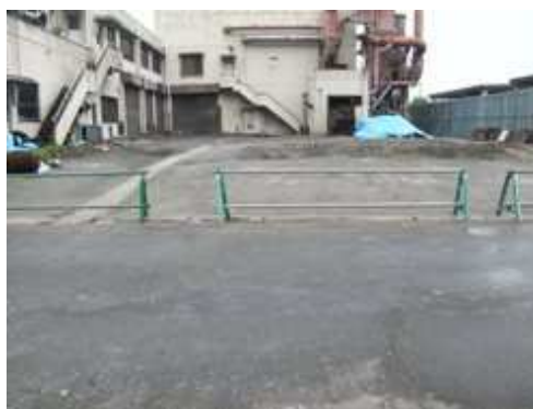
機械選別棟解体
