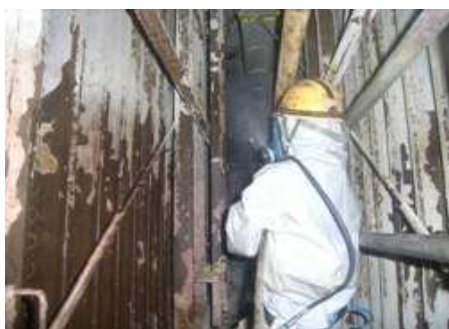
焼却棟除染工事(電気集じん器内部除染工事)
