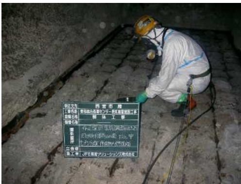
事前調査（焼却炉内残留物）
