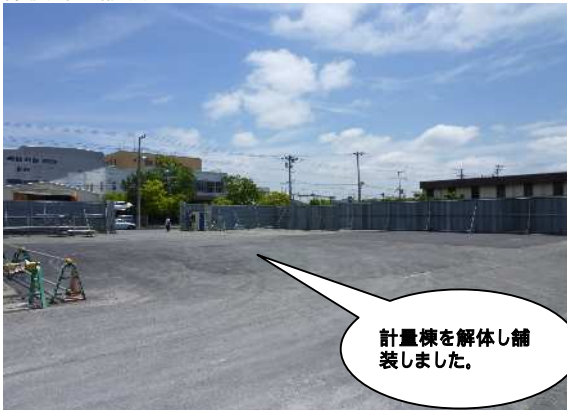
計量棟解体後跡地舗装
