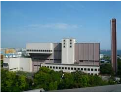
既存焼却施設（西側より）
