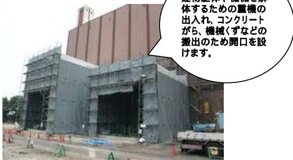
焼却棟に重機出入口を設置
