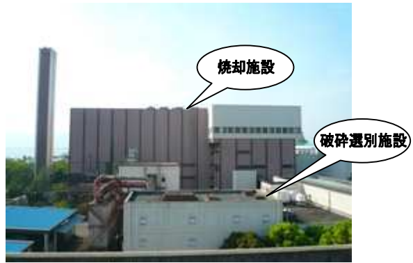
既存焼却施設及び破碎選別施設（東側より）
