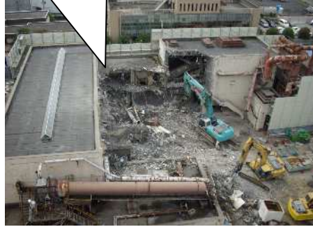
手選別室を解体しています。
