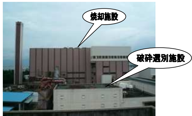
既存焼却施設及び破碎選別施設(東側より)
