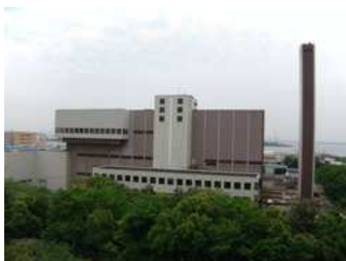
既存焼却施設(西側より)
