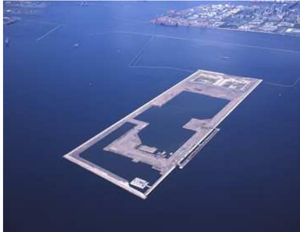
大阪湾フェニックス計画 神戸沖埋立処分場 写真提供 大阪湾広域臨海環境整備センター
