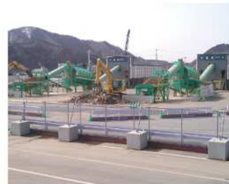
女川町災害廃棄物処理支援 (平成23年8月～平成24年3月)
