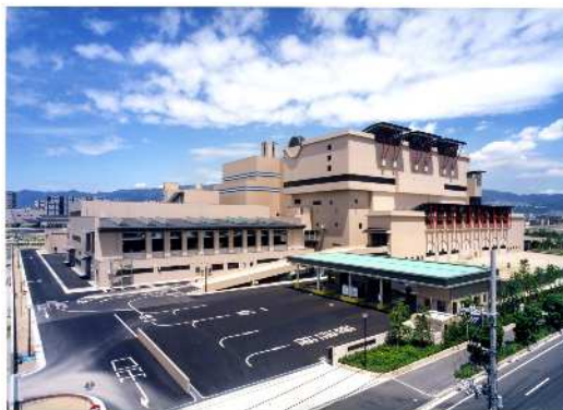
西部総合処理センター
