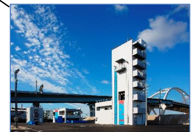
西宮市消防訓練施設
