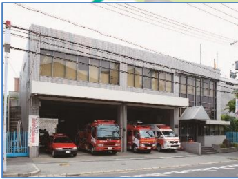
西宮消防署北夙川分署
