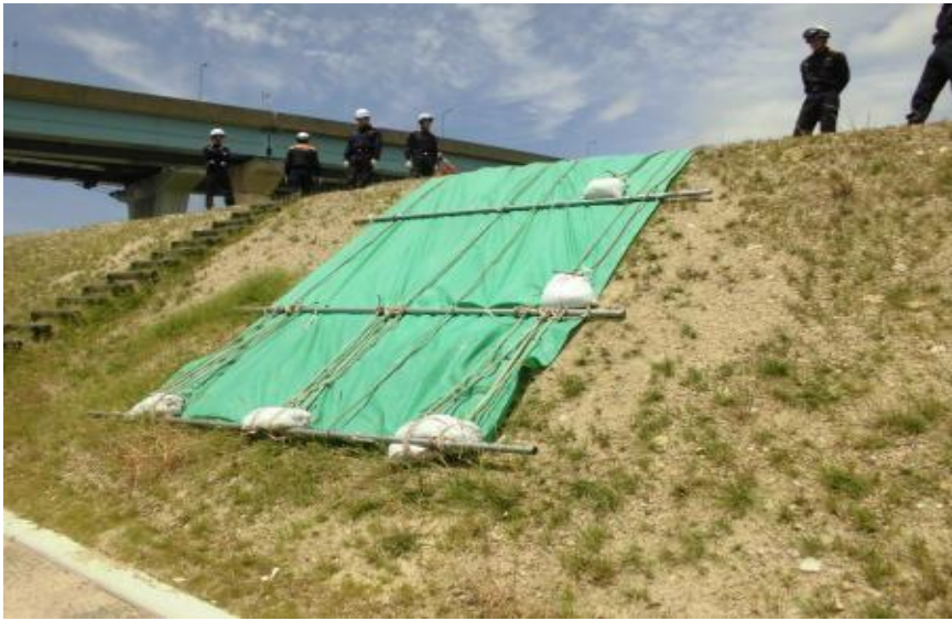
水防工法訓練
