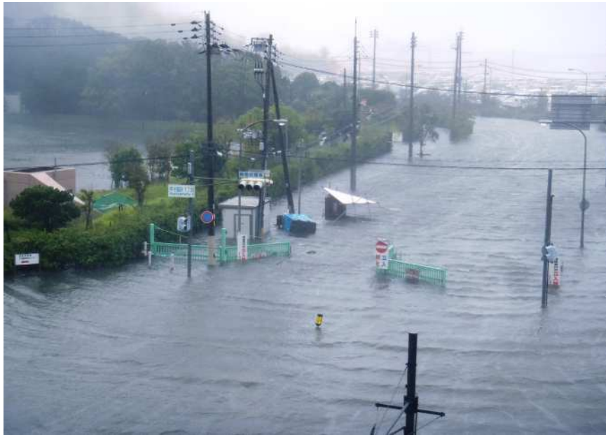
甲子園浜高潮被害状況(台風21号)
