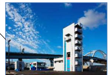
西宮市消防訓練施設
