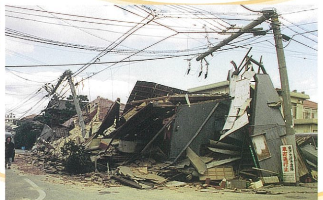
軒並みに倒壊した住宅（青木町）
