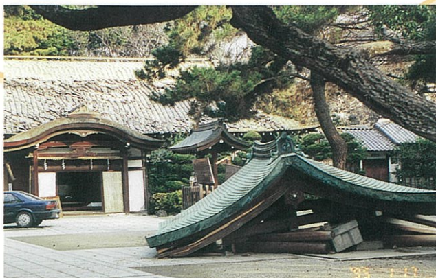
西宮神社の被災状況（社家町）
