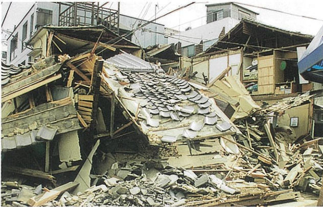
倒壊した住宅（上大市1丁目）
