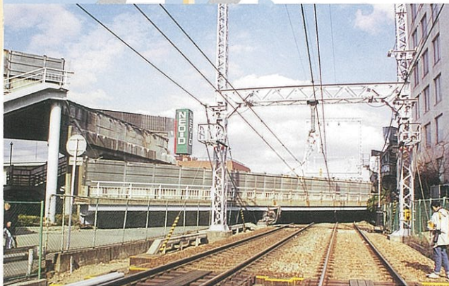
阪急・今津線上に落橋した国道171号線の陸橋 (野間町)
