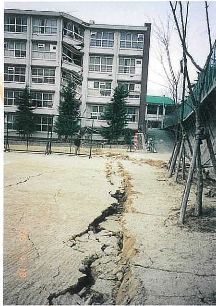
校舎グラウンドに地割れを生じ被害を受けた校舎 (高座町・市立西宮高等学校)
