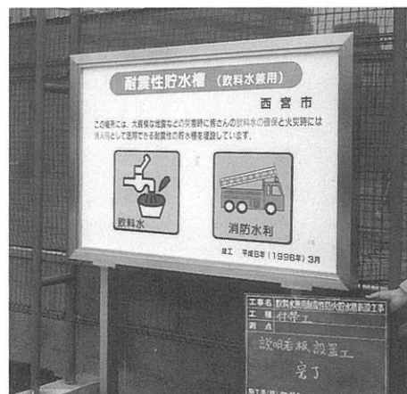
飲料水兼用型貯水槽の標識（今津中学校）
