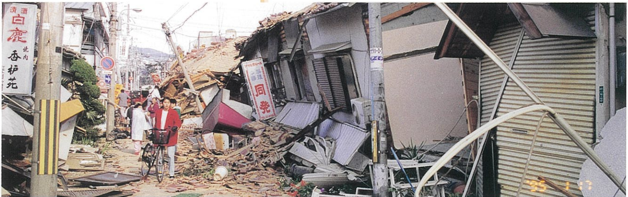
倒壊した香栞園市場（屋敷町）
