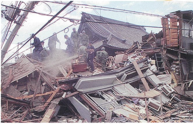
倒壊家屋からの救出活動（西福町）
