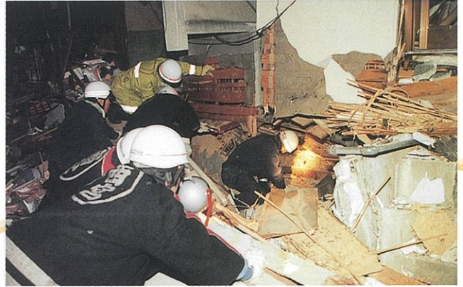
倒壊家屋内で救出活動を続ける消防団員（青木町）
