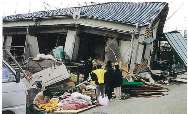
倒壊した2階建ての共同住宅では1階居住者に多くの犠牲者を生じた（青木町）
