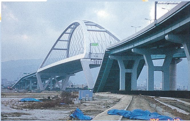
落橋した阪神高速・湾岸線では走行中の車両も犠牲となった (甲子園浜 2 丁目)
