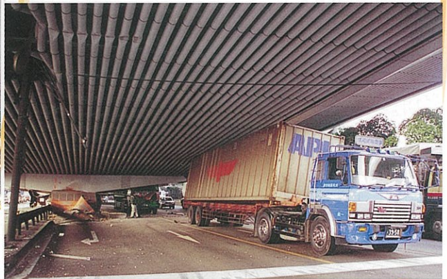
阪神高速・神戸線高架の下敷きとなった車両 (市庭町付近)
