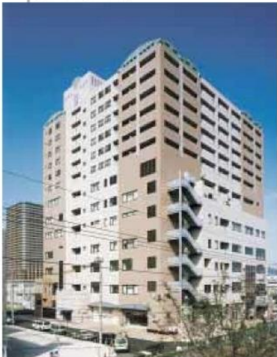
阪急西宮北口駅南地区にオープンした再開発ビル 「プレラにしのみや」
