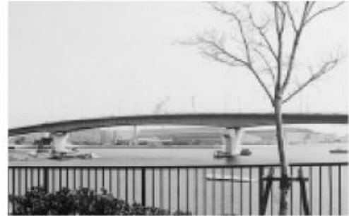
復旧した西宮大橋
