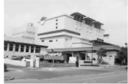
西部総合処理センター
