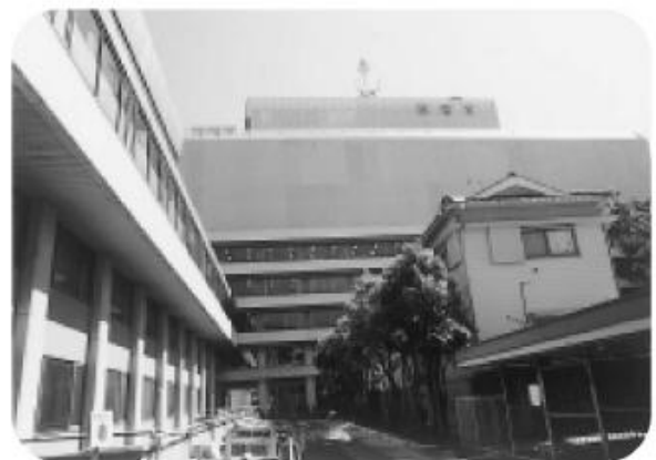
平成8年7月市役所本庁舎改修工事
