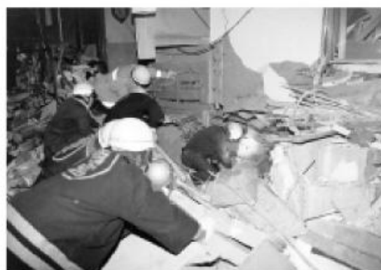
消防団員による倒壊家屋からの救出
