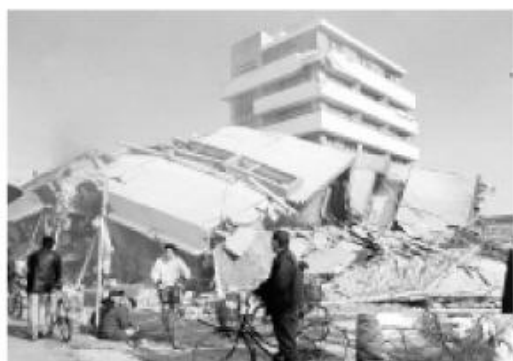
7階建てビルの倒壊 19日まで救出活動が続いた
