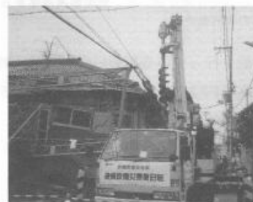
懸命に行われる電話の復旧工事。
