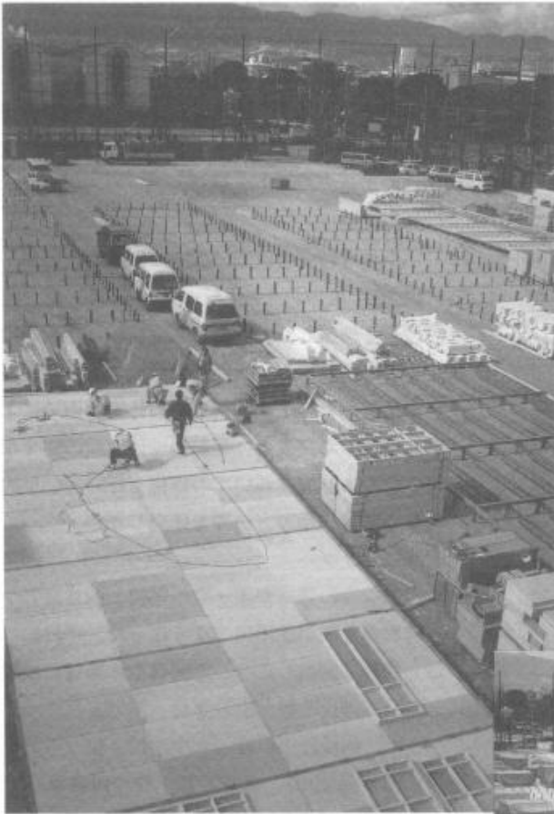
第2グラウンドに仮設住宅の建設始まる (西宮東高校)
