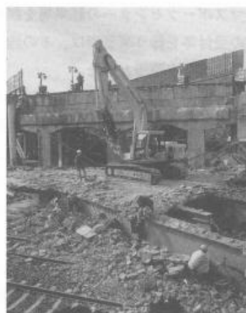
復旧作業工事
