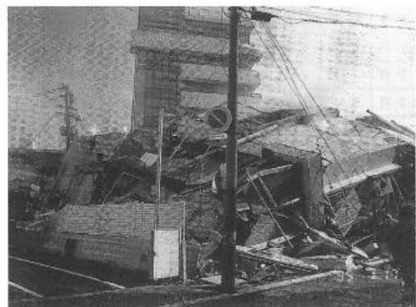
倒壊した7階建マンション(甲子園口北町)
