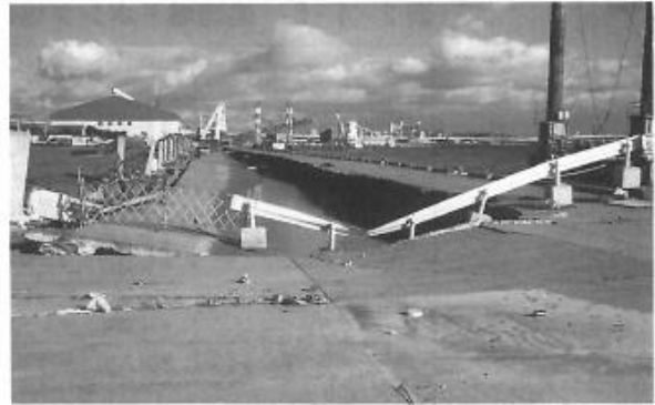
液状化による陥没した道路（西宮浜2丁目）
