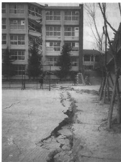
市立西宮高校のグラウンドに走る地割れ。校舎も損壊した。
