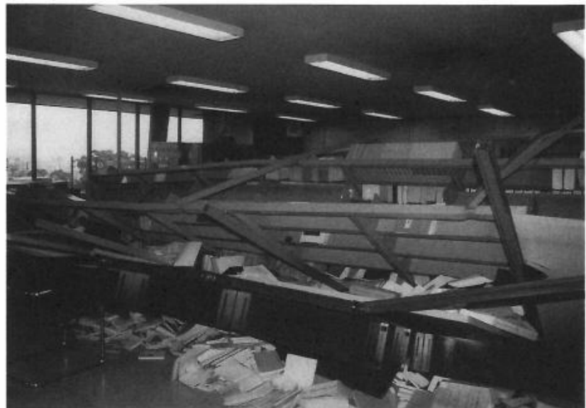
書架が倒壊した行政資料室(市役所本庁舎7階)
