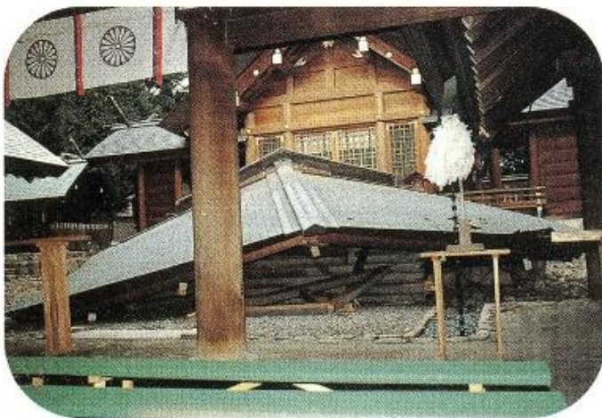
▲ 広田神社の社殿が崩壊。 市内の神社仏閣は大きな被害を受けた。
