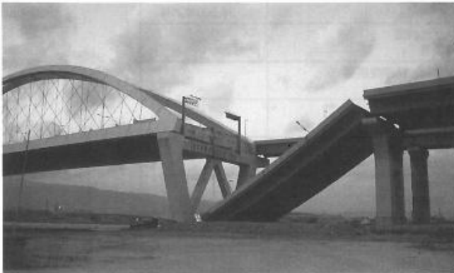
阪神高速道路湾岸線も大きな被害を受けた。
