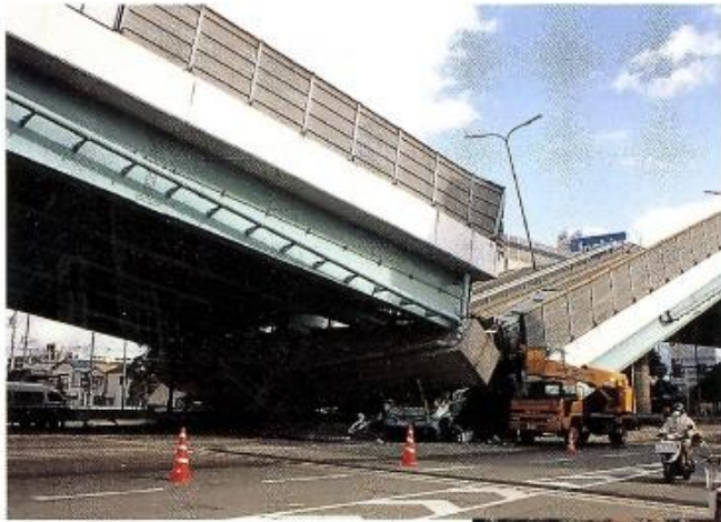
▲ 市内の3カ所で阪神高速道路が倒壊。 (甲子園付近)
