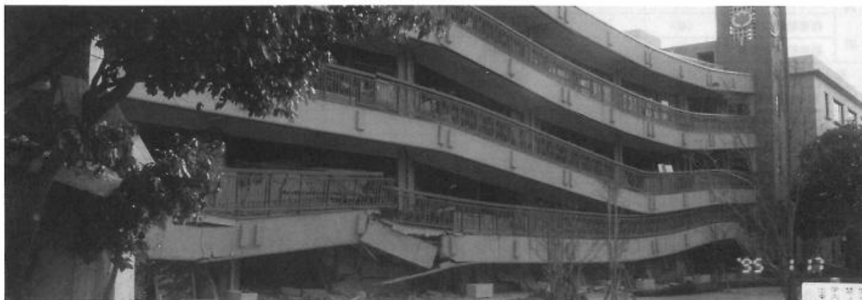
大手前女子大学の崩壊した校舎。
