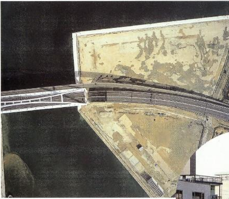
◀ 西宮、甲子園、鳴尾の埋立地では液状化現象が起り、大きな被害となった。
