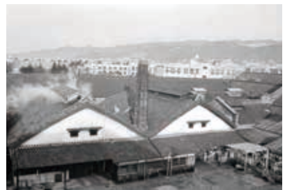
【倒壊前の双子蔵の様子】
