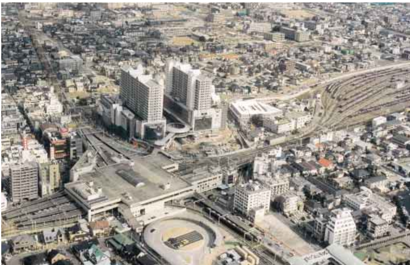
本市の都市核として、再開発、区画整理が進む阪急西宮北口駅周辺。
