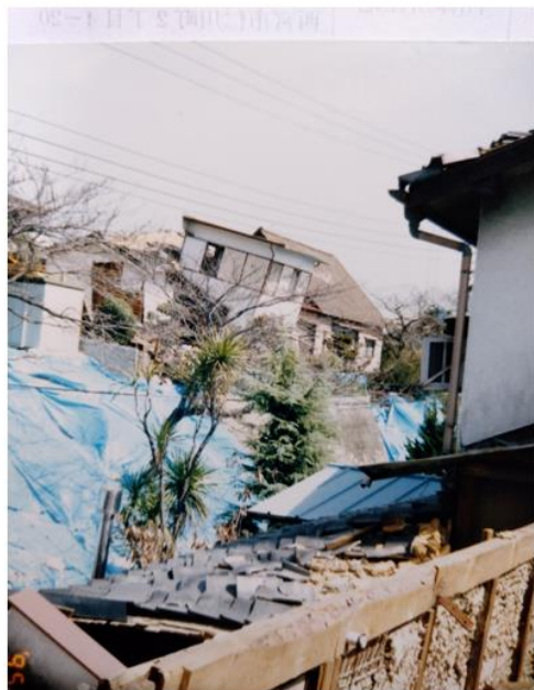
仁川町2丁目崖崩れの発生と倒壊した家屋
