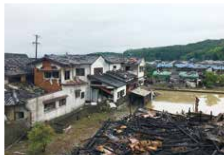
火災・爆風による周辺民家の損壊
