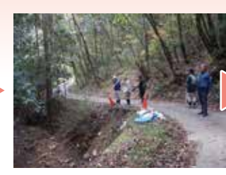
崩れそうな法面を確認
