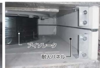
免震装置 構成 (例：アイソレータと耐火パネル)
