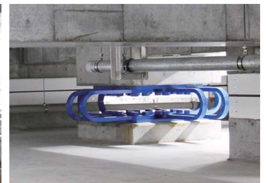
■免震層内の鋼材ダンパー (例)
