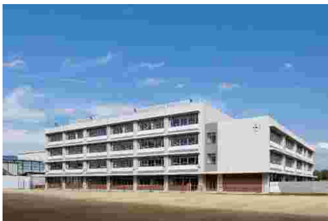
校舎の建替え（春風小学校）
