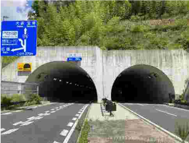
広域幹線道路の整備（国道 176 号名塩道路）
