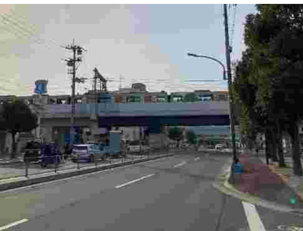
連続立体交差事業（阪神本線）
