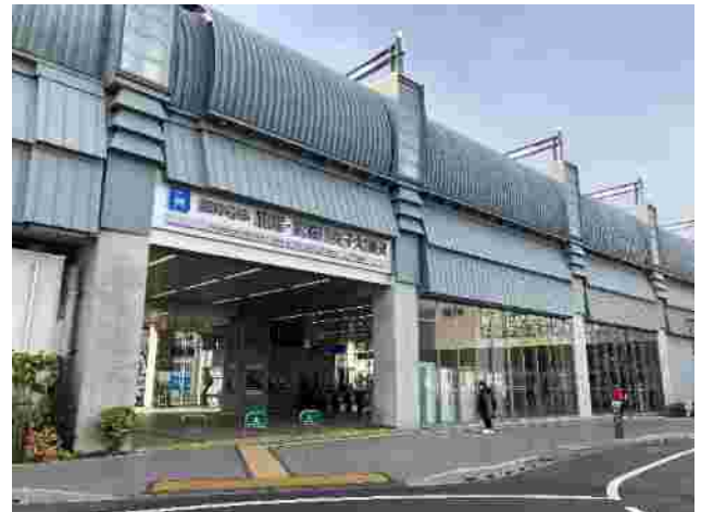
連続立体交差事業（阪神本線）
