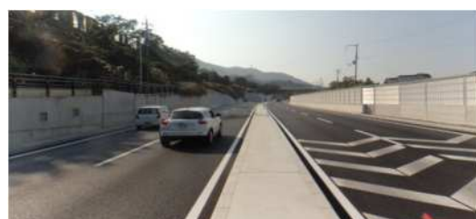
④国道 176 号線（都市計画道路）
