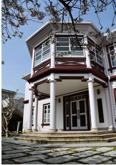
六角形の張り出し望楼
