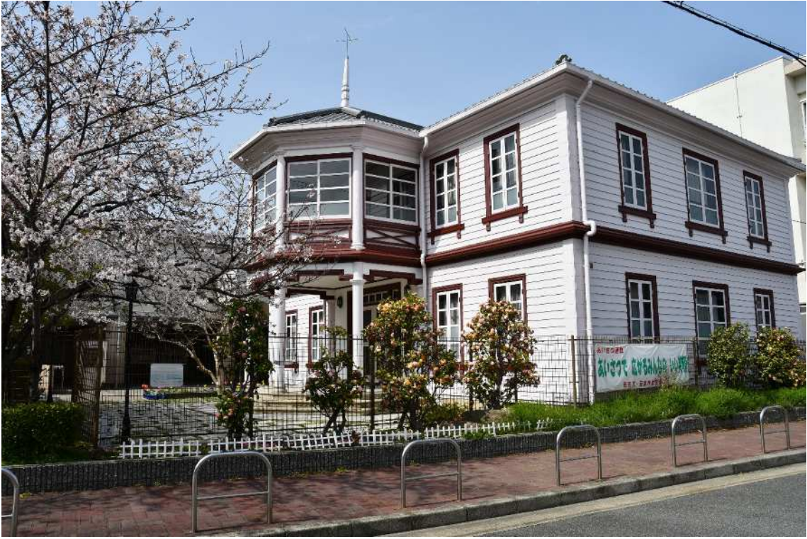
㊦東側道路から南面および東面
