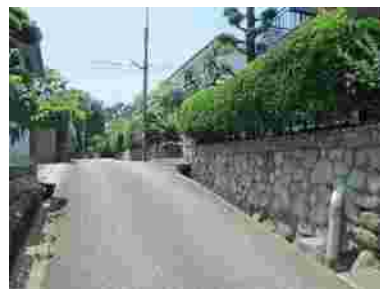
錆御影石積み
