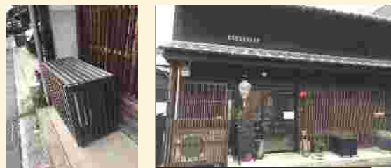
道路から見えるため、目隠しの囲いを設けたエアコン室外機
