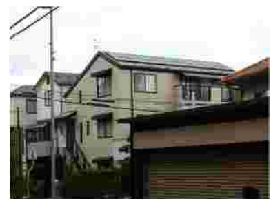
○ 屋根勾配に合わせた太陽光パネル
