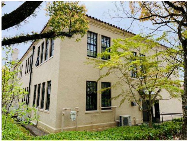
側面写真(北西角)
