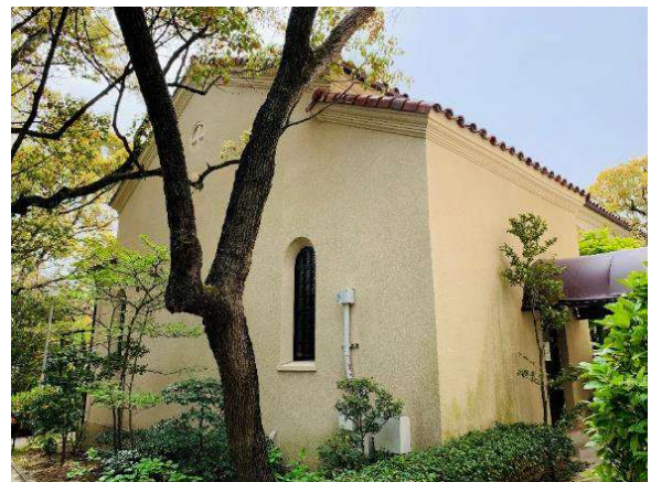
側面写真(北西角)
