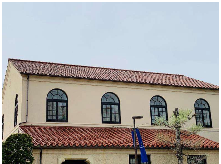
アーチ窓及びスパニッシュ瓦葺き
