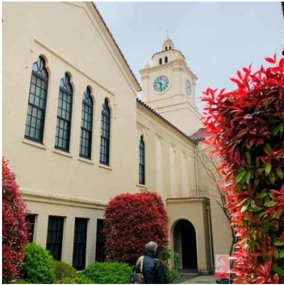
側面写真(北西角)
