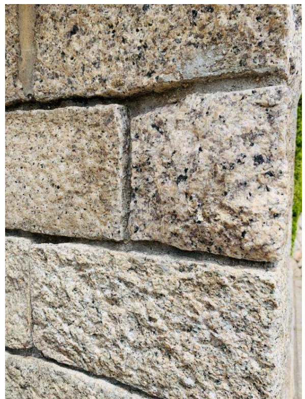
脇門柱 石貼り
