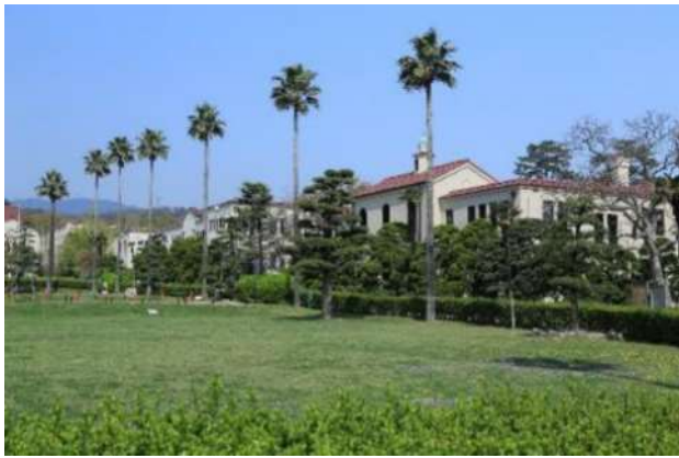
遠景写真(南東側)
