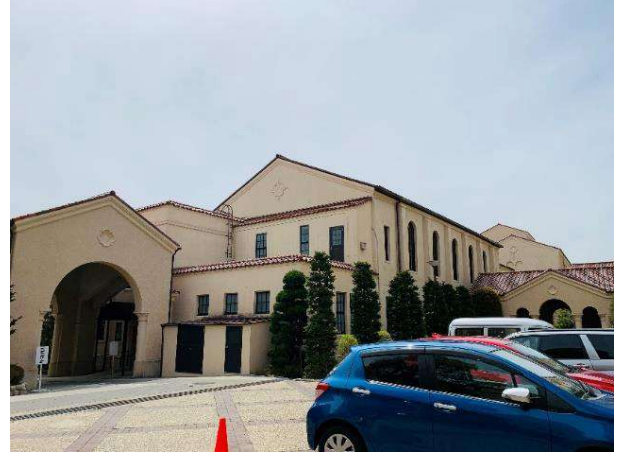
側面写真(北西角)
