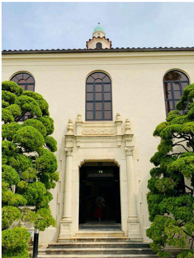
尖塔、アーチ窓及び装飾
