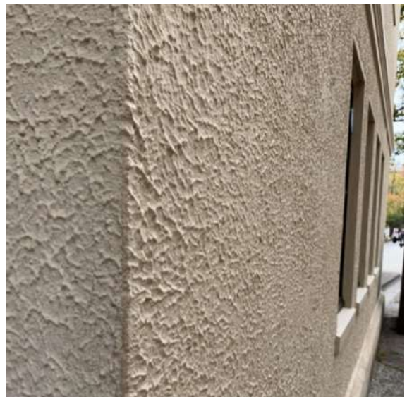
スタッコ引き抜き仕上げの上塗装
