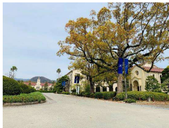
遠景写真(南東側)
