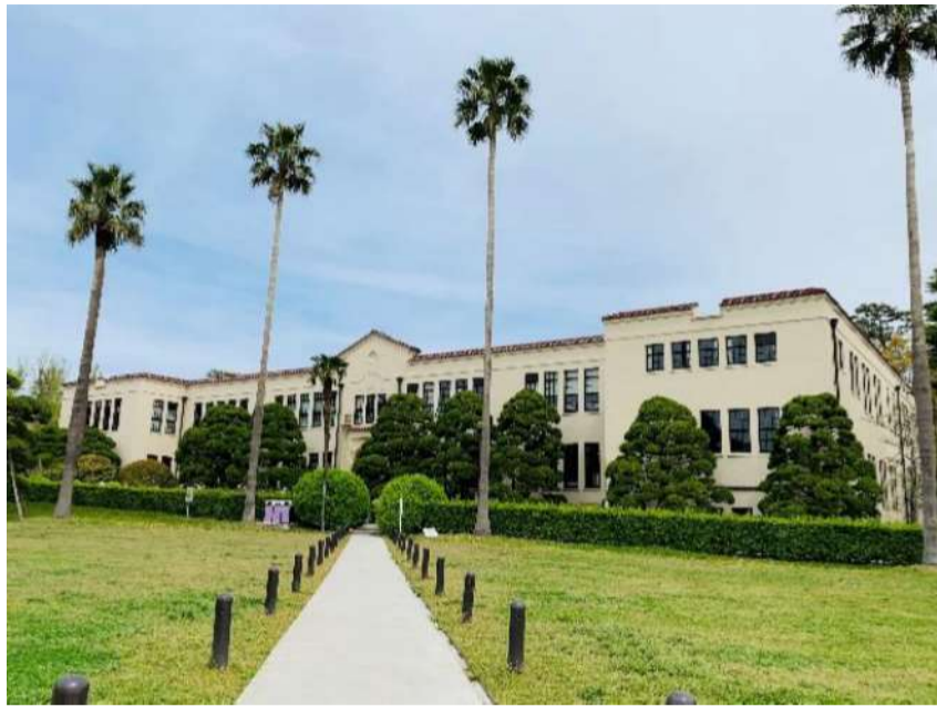
遠景写真(南東側)
