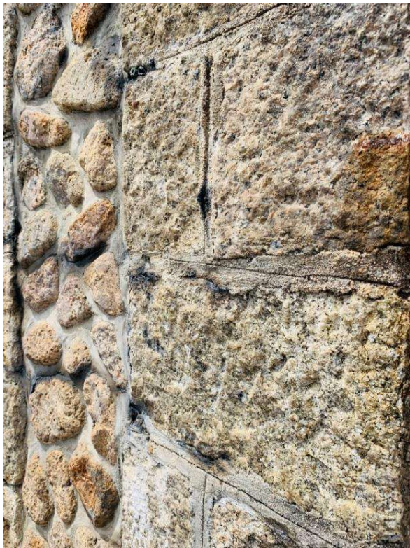
旧大学本館門柱 石貼り
