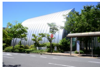
壁面との区別がつかない屋根の例
