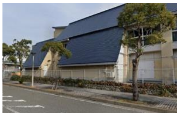
急勾配で見付面積の過半を占める屋根の例
