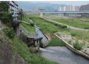
武庫川の取水口
