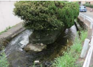
百間樋の出口の分水路
